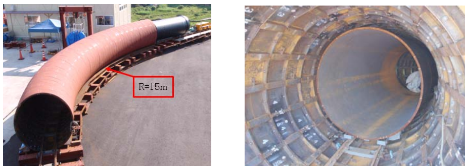
写真1 4m直管の通過試験
